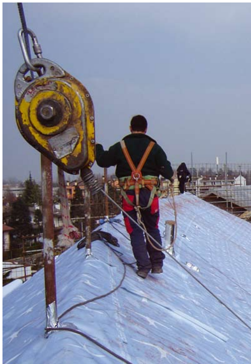
La linea vita non è a norma e il lavoratore non indossa l'elmetto.
