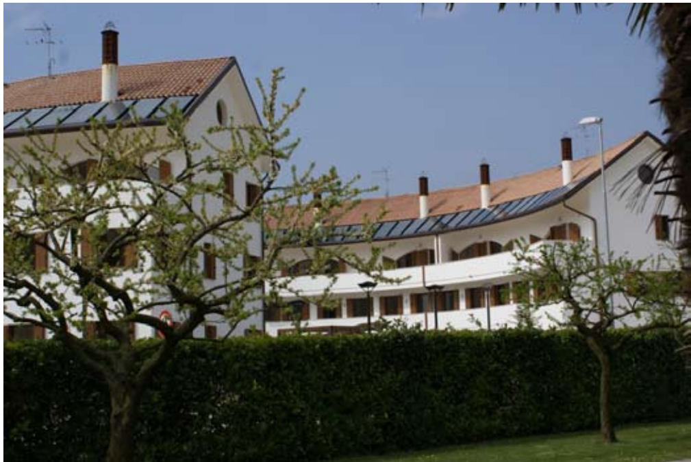
Scorcio laterale dei fabbricati principali.
