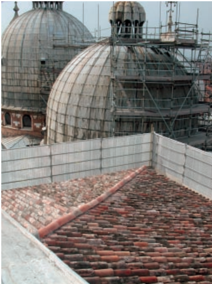
Porzione di tetto già recuperata.
