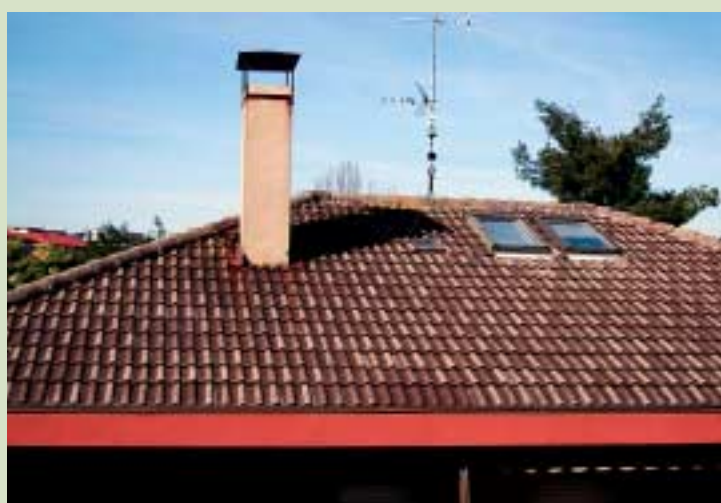
Fig. 1 - Coperture degli anni '70 e '80 realizzate con tegole in cemento colorate superficialmente, che, a distanza di anni, presentano zone nelle quali risulta visibile il colore di base sotto lo strato pigmentato. Roofs dating back to the '70s and '80s, made with tiles whose surface has been coloured: years later, these roofs show areas where the base colour is visible under the pigmented surface layer.
