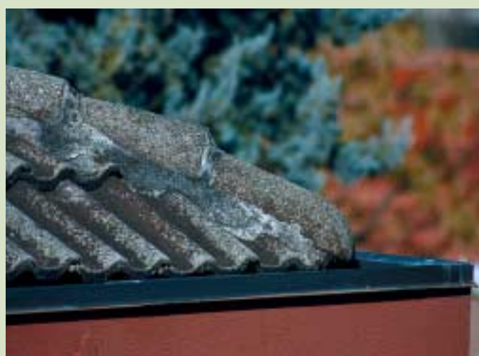
Fig. 1 - Coperture degli anni '70 e '80 realizzate con tegole in cemento colorate superficialmente, che, a distanza di anni, presentano zone nelle quali risulta visibile il colore di base sotto lo strato pigmentato. Roofs dating back to the '70s and '80s, made with tiles whose surface has been coloured: years later, these roofs show areas where the base colour is visible under the pigmented surface layer.
