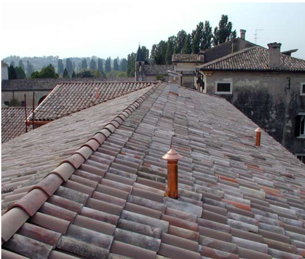
Vista della copertura finita ad intervento ultimato.
