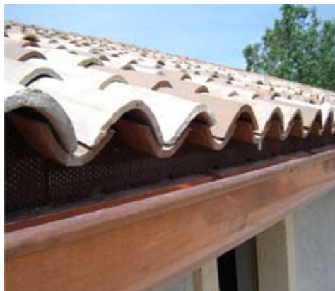
Dettaglio della linea di gronda.
