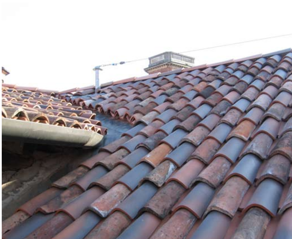
Il manto di copertura a seguito dell'intervento di recupero.
