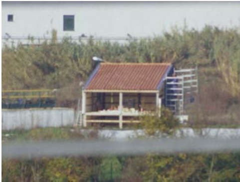
Fig.9,10 Fasi di montaggio dell'edificio sperimentale realizzato nel mese di novembre presso un laboratorio esterno dell'Università degli studi di Ancona. In alto è visibile l'afase di realizzazione della struttura portante. In basso si vede l'edificio non ancora completato nelle pareti perimetrali esterne.
