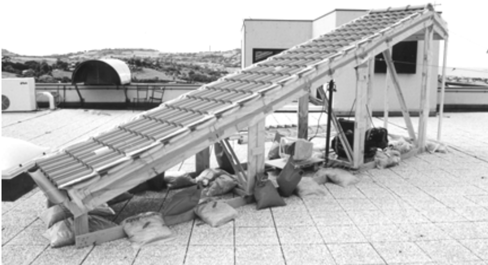
Fig. 2 Falda di copertura utilizzata per la sperimentazione. Prima della valutazione in esterno la stessa falda è stata utilizzata per misure sulla capacità di dissipazione del calore per mezzo di un sistema di irraggiamento simulato (piastre radianti di potenza nota). Ciò ha permesso di verificare l'attendibilità dei risultati forniti.
