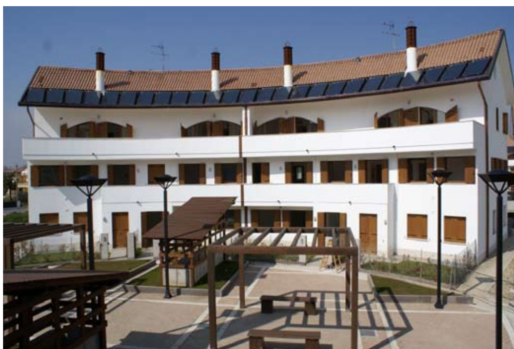
Vista dal cortile interno.
