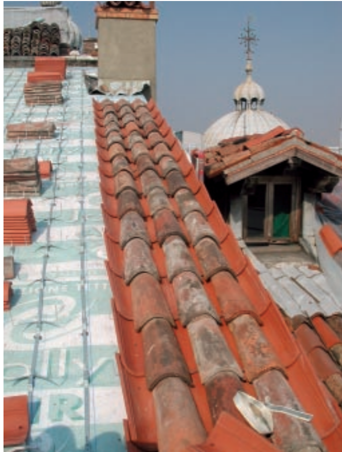
Fase di posa: si notano i “canali” nuovi e le “coperte” di recupero.
