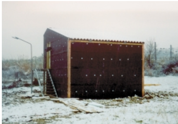
La struttura realizzata nel laboratorio esterno della Facoltà di Ingegneria dell'Università di Ancona.
