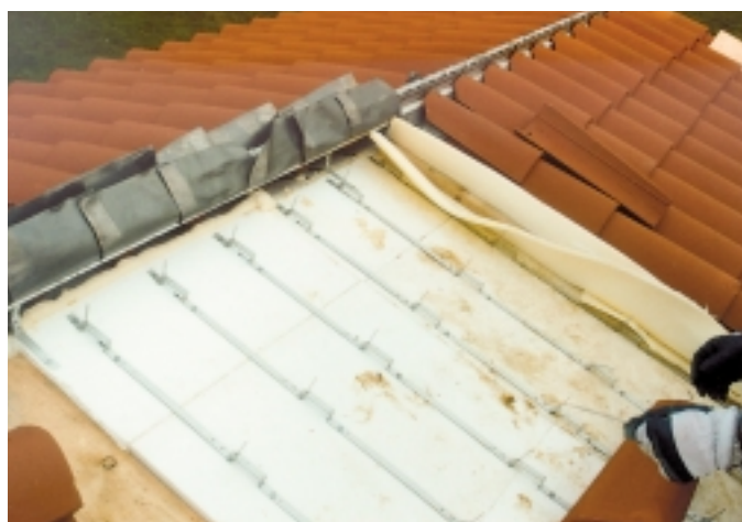
Fase di montaggio del sistema C. È visibile il sistema atto a impedire scambi di aria e calore tra i condotti.
