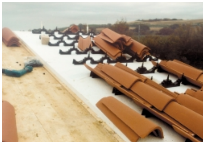
Fase di montaggio del sistema A: culla in polipropilene.
