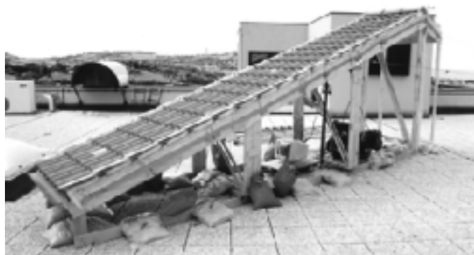
2. Falda di copertura utilizzata per la sperimentazione.
