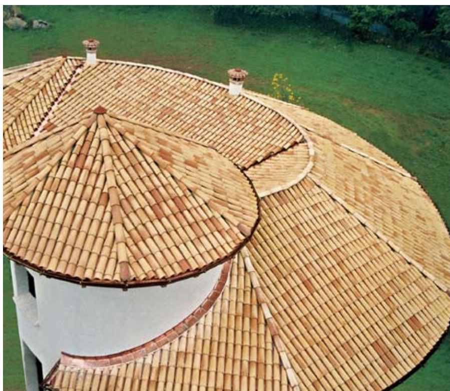
Vista d'insieme della copertura.
